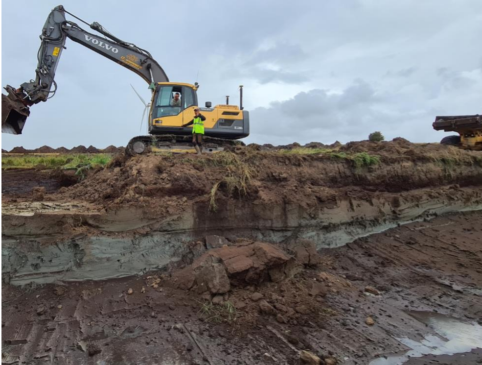
Projektledare Christoffer Bonthron stämmer av med entreprenören Henrik Mårtensson.
