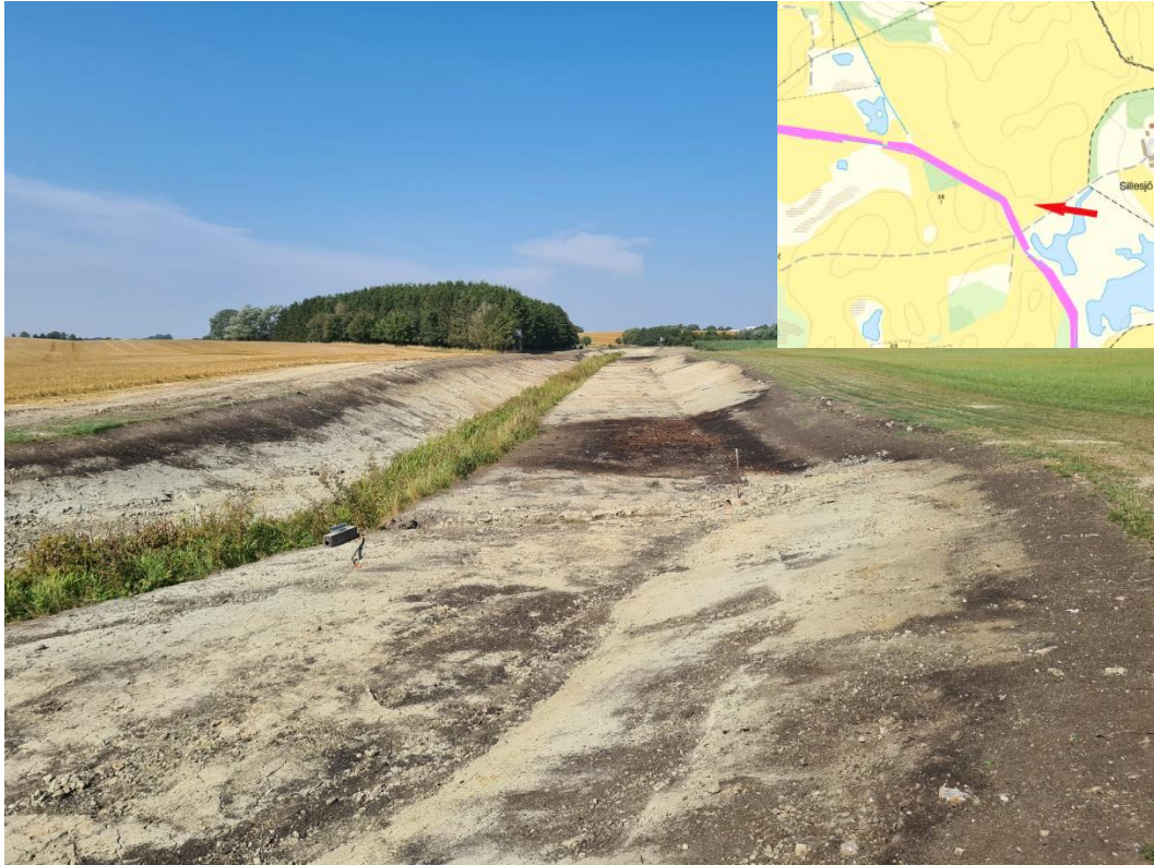
Delsträcka 19 övre på Sillesjö. Tvåstegsdike på norra sidan med 6 meter bred terrass, kantavplaning på södra sidan.
