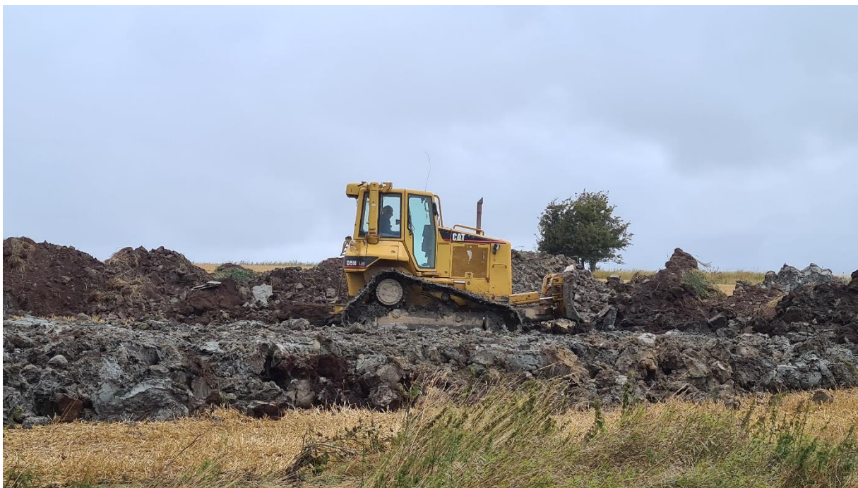
Schaktmassorna breds ut över närliggande svackor landskapet.
